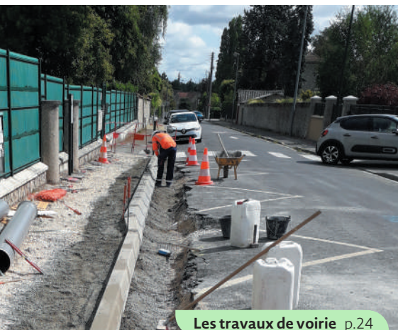
Les travaux de voirie p.24
