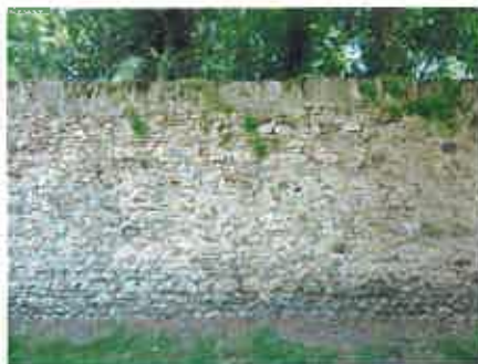
Les murs traditionnels (en maçonnerie de moellons enduits à pierre vue)
