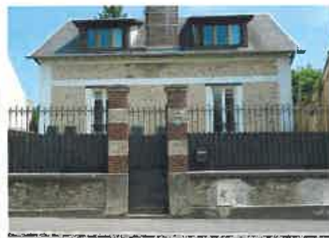
Les murs bahuts maçonnés avec grille de fer forgé (avec ou sans tôle)
