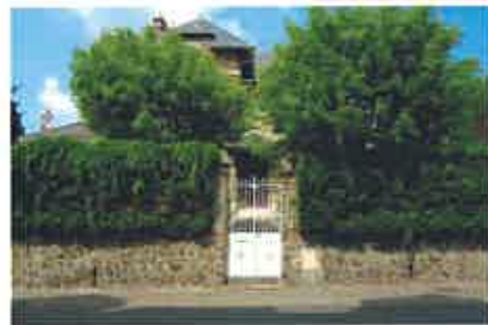
Les murs bahuts maçonnés avec grille de fer forgé (avec ou sans tôle)
