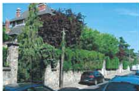
Les murs bahuts maçonnés avec grille de fer forgé (avec ou sans tôle)
