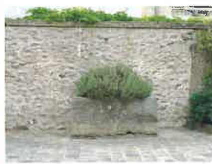
Les murs traditionnels (en maçonnerie de moellons enduits à pierre vue)
