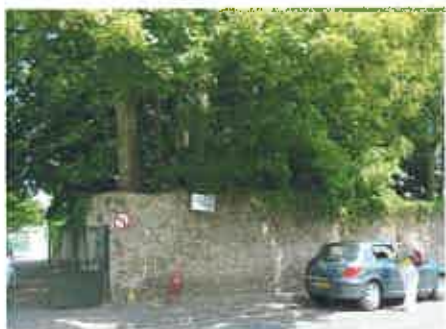
Les murs traditionnels (en maçonnerie de moellons enduits à pierre vue)
