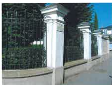
Les murs traditionnels (en maçonnerie de moellons enduits à pierre vue)
