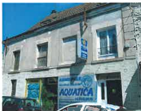
l'enduit inadapté et l'enseigne sur le trumeau
