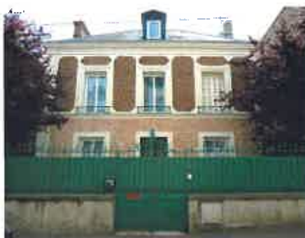
Les murs bahuts maçonnés avec grille de fer forgé (avec ou sans tôle)
