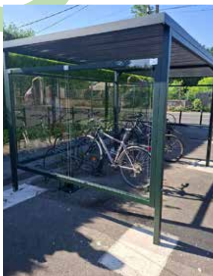
Pose de rack à vélos rue de la Prairie.
