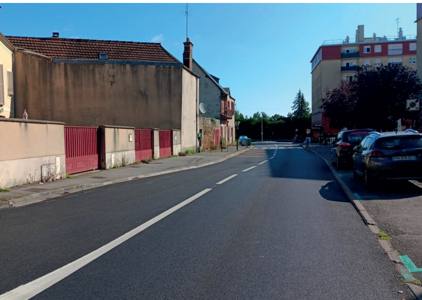
Réfection de la rue des Marais
