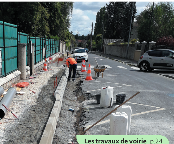
Les travaux de voirie p.24
