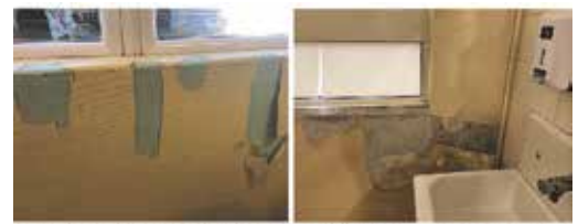
Le CLAE (centre d'accueil) de la Louvière EELV/Rambouillet
